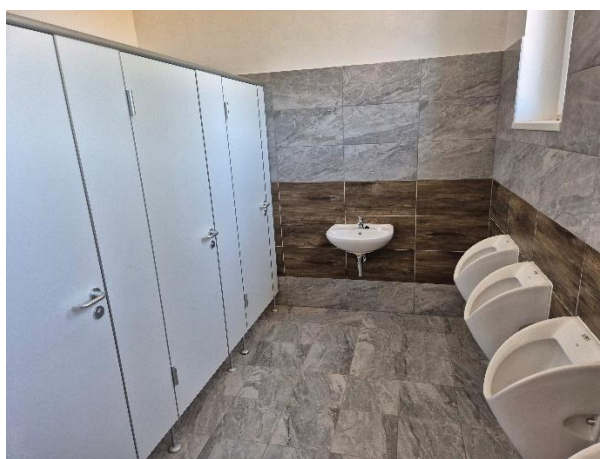
Rekonstruovaná chlapecká WC
